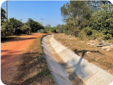
ซ่อมแซมระบบส่งน้ำ สาย RMC ความยาว 0.250 กิโลเมตร อ่างเก็บน้ำห้วยซึ่หิน โครงการชลประทาน สกลนคร ตำบลสร้างคือ อำเภอภูพาน จังหวัดสกลนคร
