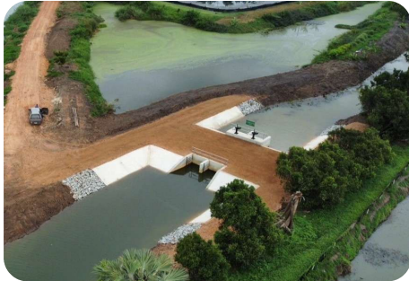
อาคารบังคับน้ำบ้านทางข้ามน้อย ตำบลหัวไทร อำเภอบางคล้า จังหวัดฉะเชิงเทรา
