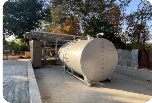
ก่อสร้างอาคารคั่งน้ำมัน โครงการก่อสร้าง สำนักงานชลประทานที่ 7 ตำบลนาคู่ อำเภอนาแก จังหวัดนครพนม
