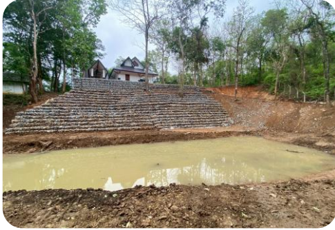
ซ่อมแซมลาดตลิ่งอาคารควบคุมการจัดการน้ำ (SCADA) และเครื่องมือตรวจวัดพฤติกรรมเขื่อน โครงการชลประทาน เชียงใหม่ ตำบลตอนแก้ว อำเภอแมริ่ม จังหวัดเชียงใหม่
