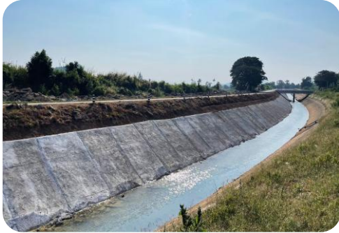
ซ่อมแซมคอนกรีตตาดคลองส่งน้ำสายใหญ่ ช่วงกม.2+350 ความยาว 0.315 กิโลเมตร โครงการส่งน้ำและบำรุงรักษาปรางบุรี ตำบลหนองตาแต้ม อำเภอปรางบุรี จังหวัดประจวบคีรีขันธ์
