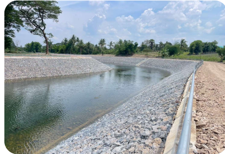
อาคารป้องกันตลิ่งลำห้วยแม่ประจันต์ ระยะที่ 2 (บ้านหนองไม้) ระยะทาง 800 เมตร ตำบลหนองหญ้าปล้อง อำเภอหนองหญ้าปล้อง จังหวัดเพชรบุรี
