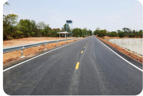
ถนนทางเข้า ระยะทาง 1.20 กิโลเมตร อ่างเก็บน้ำลุ่มทุก โครงการชลประทานสุรินทร์ ตำบลตาเบา อำเภอปราสาท จังหวัดสุรินทร์
